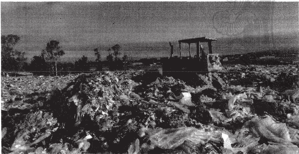
Imagen 10. Compactación con tractor sobre orugas, marca Caterpillar Modelo D4 del municipio de Cortazar.
