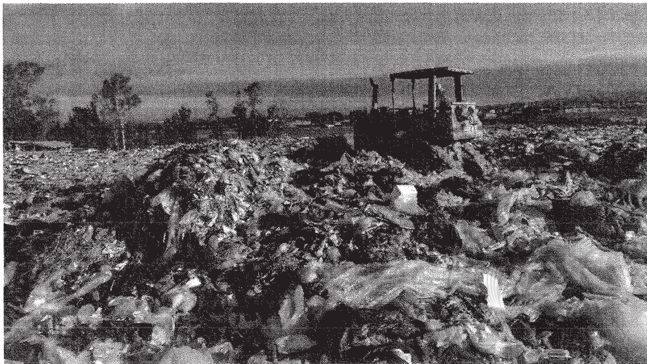
Imagen 44. Compactación de RS con maquinaria pesada.
